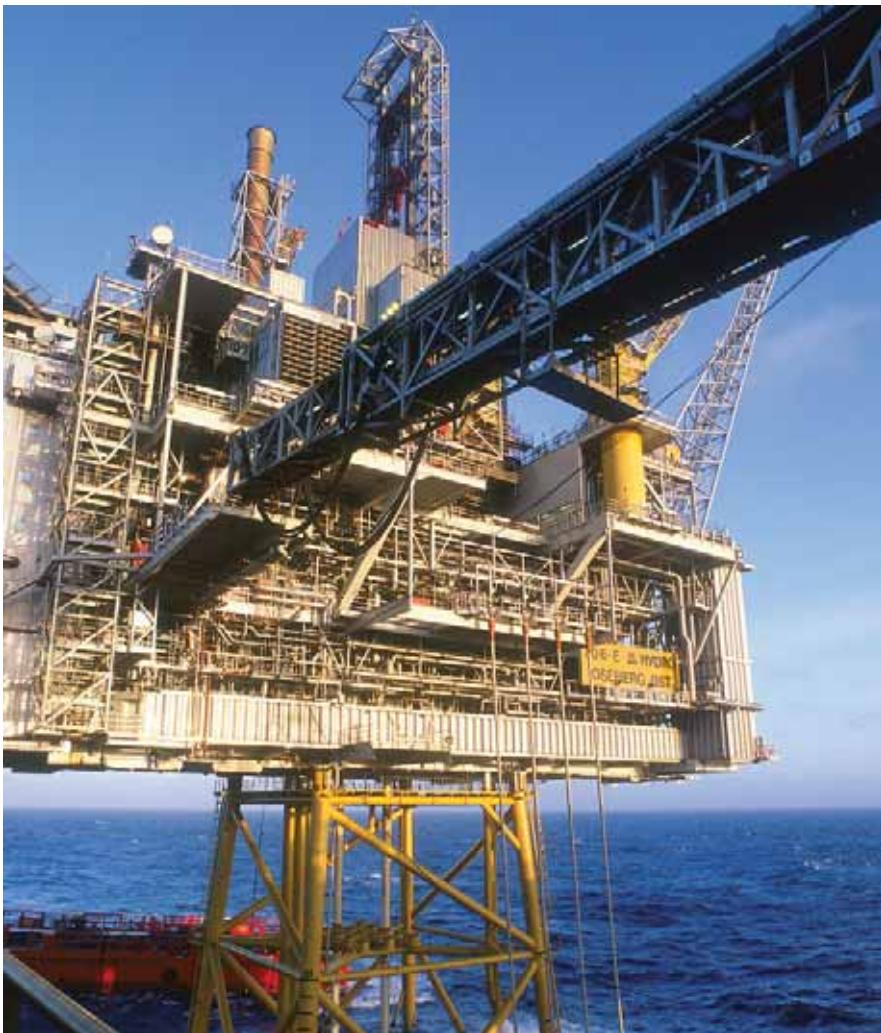
Im Offshore-Bereich – hier auf einer Ölplattform – eingesetzte Kombinationen sind mit speziellem Oberflächenschutz versehen, um der extrem korrosiven Umgebungsatmosphäre standhalten zu können.
